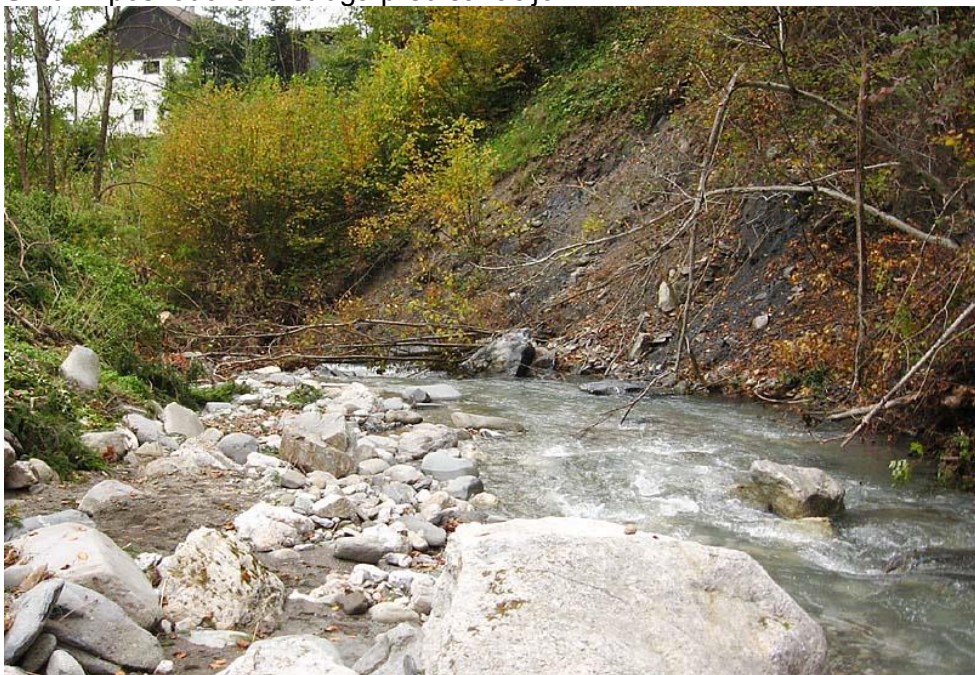
Slika 1: poškodovana struga pred sanacijo
