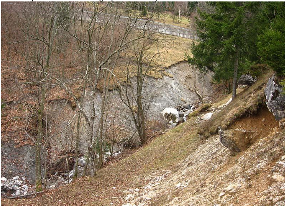
Slika 3: poškodovana struga pred sanacijo
