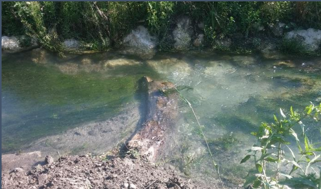
Sonaravno zoženje struge z odbijačem/sidranim deblom
